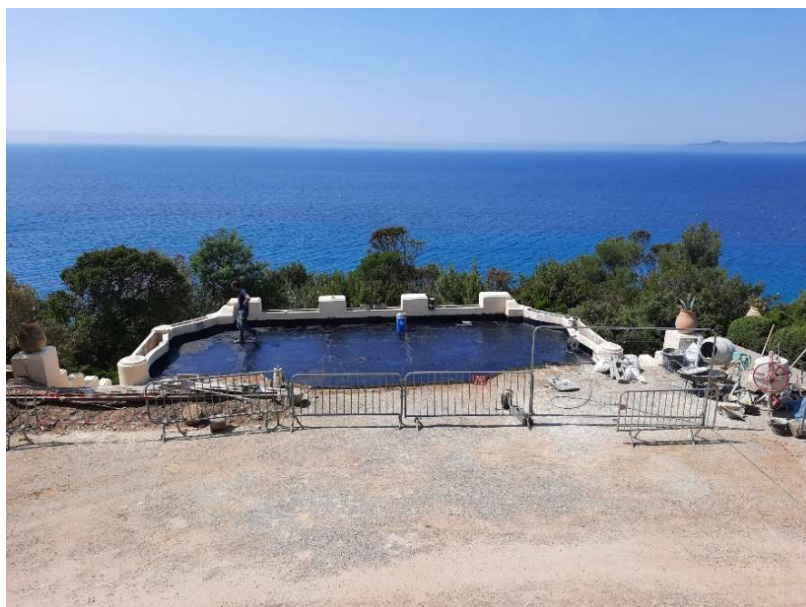
Nymphée (bâtiment sous l'esplanade) : consolidation de la structure et étanchéité
