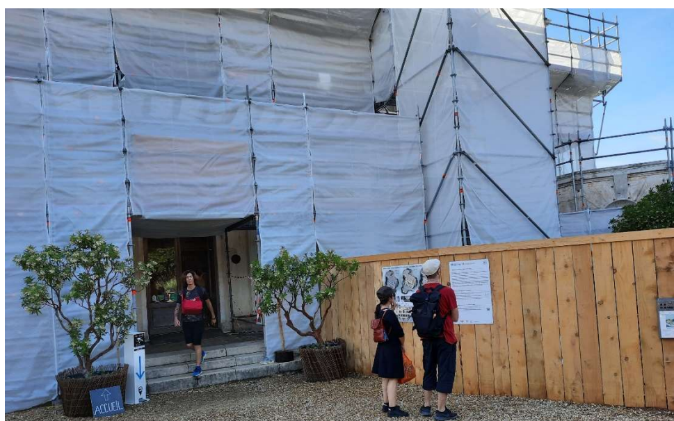
Visiteurs à l'entrée du Domaine du Rayol, pendant les travaux
