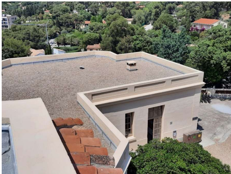
Conciergerie : isolation thermique et étanchéité de la toiture + reconstitution de l'acrotère
