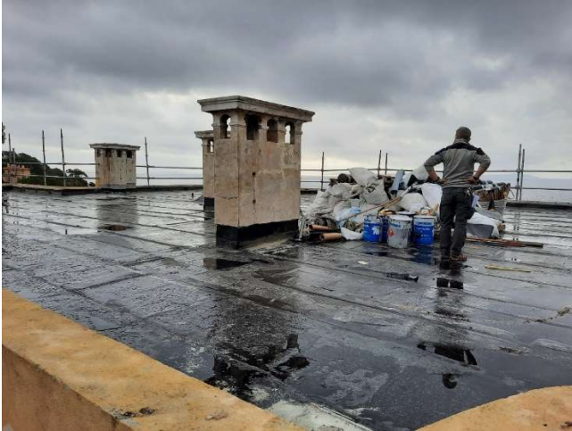
Hôtel de la Mer : isolation thermique et étanchéité de la toiture
